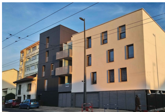
Saint-Max - Villa Carnot - Bourbon Zanon architectes
